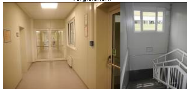
Gänge und Treppenhäuser, erfüllen aktuelle Bedingungen an den Brandschutz
